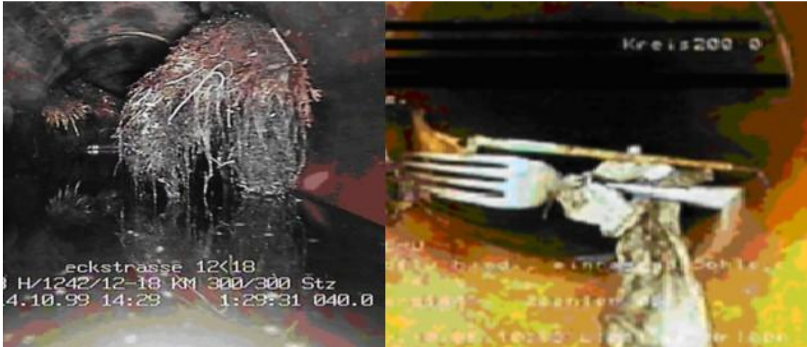
(Fotos:© Stadtentwässerung Frankfurt am Main SEF)
